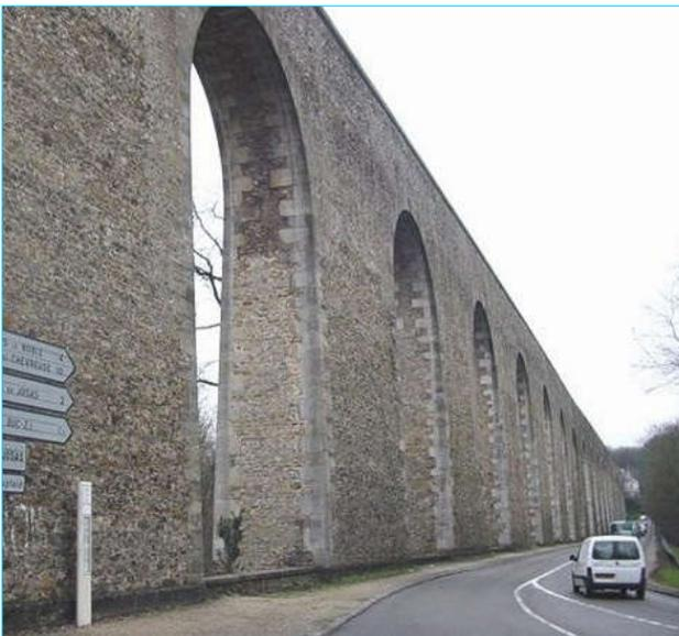
**Ses caractéristiques** : l'ouvrage a une longueur de 580 m et une hauteur totale de 24 m. Il est composé de deux rangées de 19 arcades superposées, de 21 m de hauteur. Les piles des arcades inférieures sont espacées de 9 m ; épaisses de 4 m, elles ont des fondations de 24 m. Au sommet, l'aqueduc mesure 1,00 m de large, profond de 1,90 m, et couvert de dalles en pierre.
