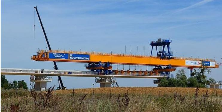
Le viaduc de la ligne 18, en construction, va traverser le plateau de Saclay. **C'est une poutre de lancement qui assemble le tablier...** soutenu par 188 piles, sur 6,7 km de longueur. Sur cette section aérienne, 3 gares vont être construites entre le plateau de Saclay et Massy (la mise en service est prévue en 2026).
